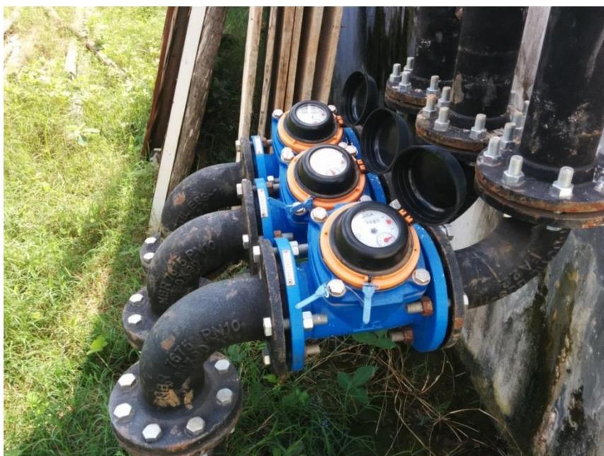
**Ilustração 11 - Hidrômetros dos poços P02, P03 e P04 na entrada do CTA**
