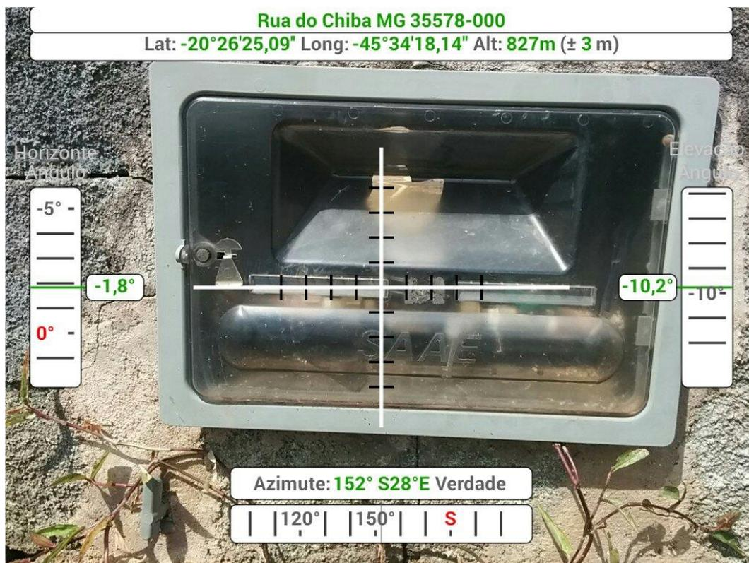
**Ilustração 10 - Cavalete de ligação predial padronizado, com hidrômetro**
