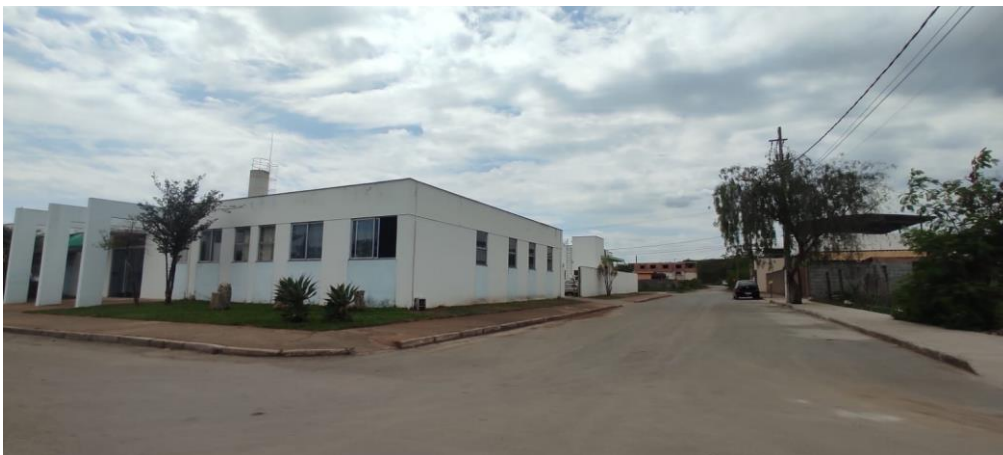
Foto 07: Esquina da Unidade
