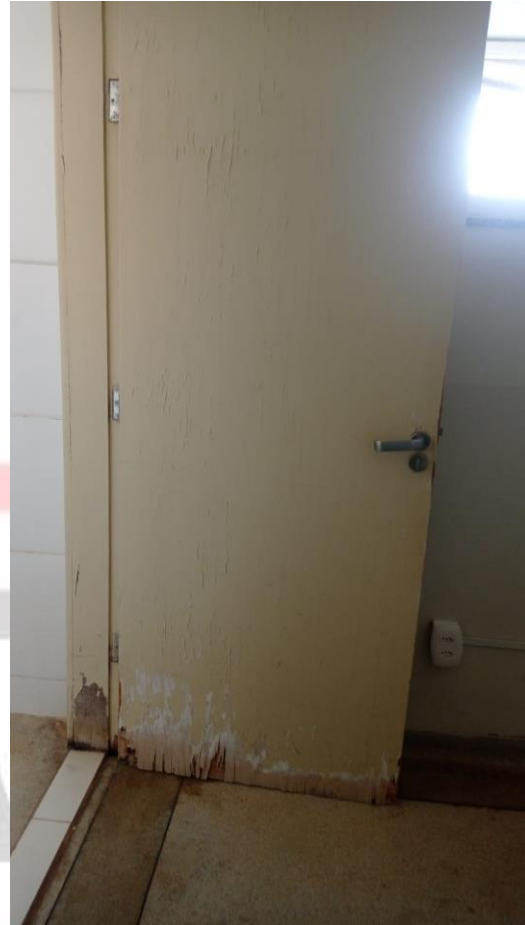
Foto 06: Porta do banheiro
